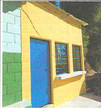
FOTO 1: CONSTRUCCIÓN DE PAREDES DE LA COCINA REEMPLAZANDO LAS QUE PRESENTABAN FISURAS Y DESPRENDIMIENTO PROBABLEMENTE POR HUMEDAD
