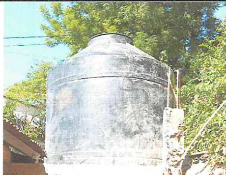
FOTO 2: FUNDICIÓN DE COLUMNAS, ARMADO Y FUNDICIÓN DE LOSA, INSTALACIÓN DE TINACO DE 2500 LITROS Y CONEXIÓN DEL SISTEMA HIDRÁULICO
