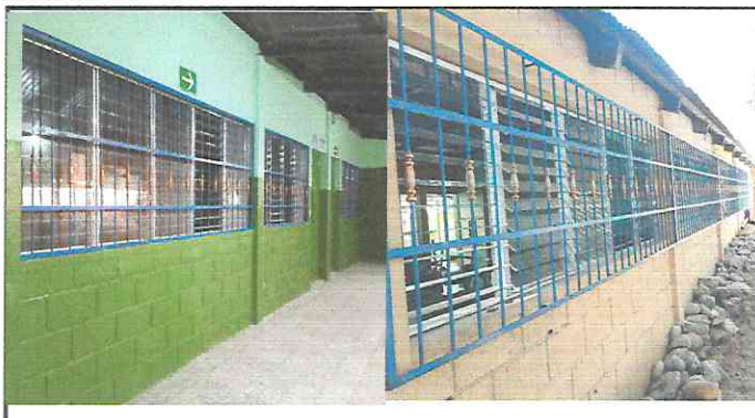
FOTO 4: BALCONES DE METAL INSTALADOS EN LAS AULAS.
