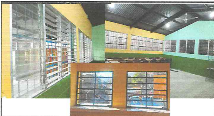
FOTO 3: VENTANAS INSTALADAS DE ALUMINIO MILL FINISH EN AULAS Y DE METAL CON CUERPO DE VIDRIO EN COCINA
